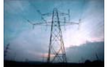
RWE soll über brüchige Strommasten Auskunft geben
