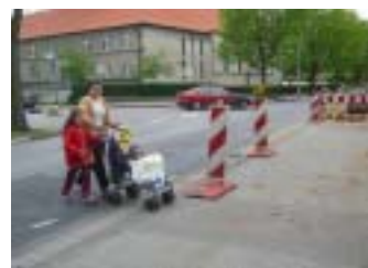
Die Mittelinsel an der Schultenstraße – hier während der Kanalbauarbeiten
